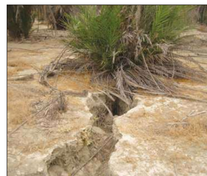
شکل شماره (۲): شکاف ناشی از نشست زمین در دشت منوجان
