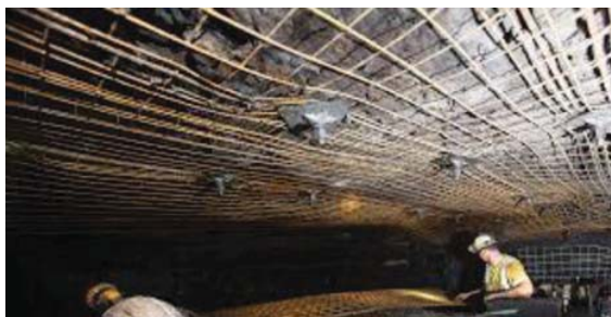
شکل ۴. کاربرد سیستم نگهداری پیچ سنگ
