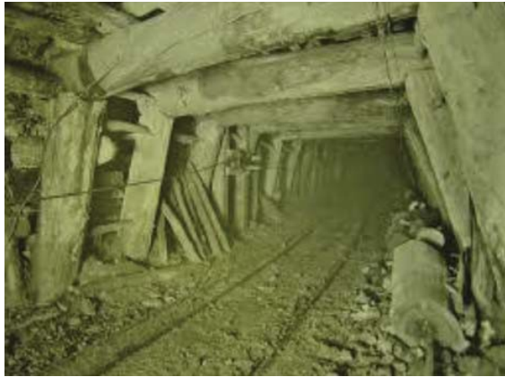
شکل ۳. استفاده از روش‌های سنتی در نگهداری تونل‌ها و فضاهای زیرزمینی
